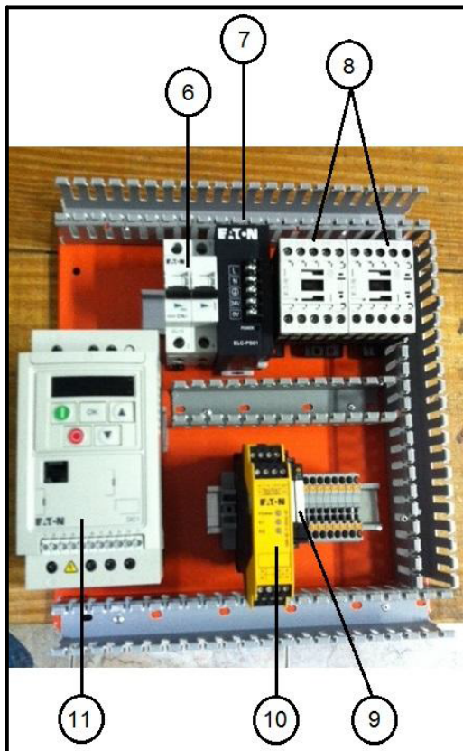
Figura 4 – Componentes do Quadro de Comando
